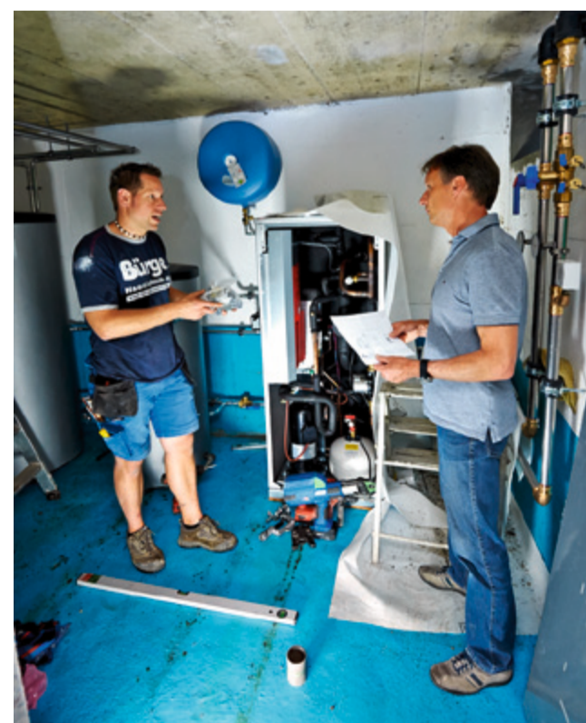
Der frühere Öltankkeller im Haus Bucher in Windlach: Daniel Kunz (r.) und Heizungsinstallateur Markus Baumgartner bei der Installation einer Wärmepumpenanlage.
