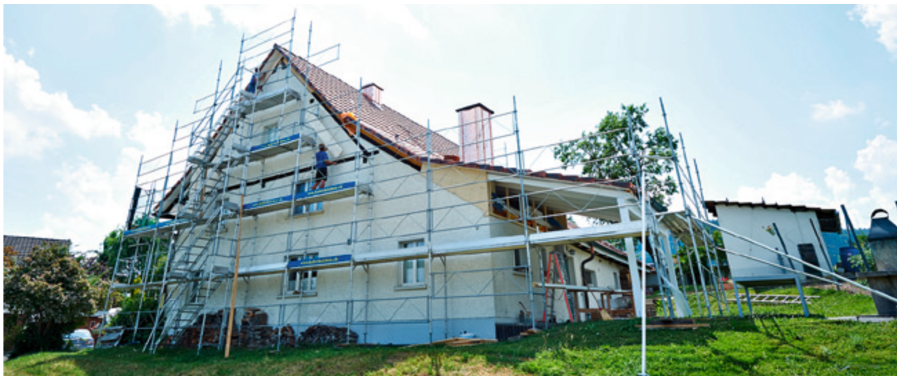
Sanierungsobjekt: Vor dem Einbau der Wärmepumpe wird das ehemalige Bauernhaus in Windlach ZH besser gedämmt.
