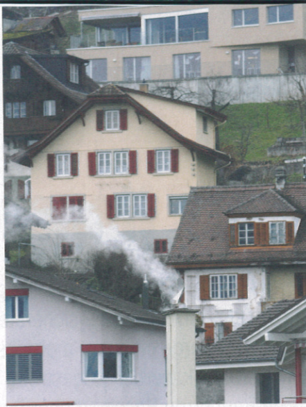
Der Schweizer Gebäudepark verschlingt auch wegen überalterter Heizungsanlagen zu viel Energie. Die Qualitätssicherung durch das WP-Modul soll die Installation und Wartung zeitgemässer Anlagen erleichtern.
