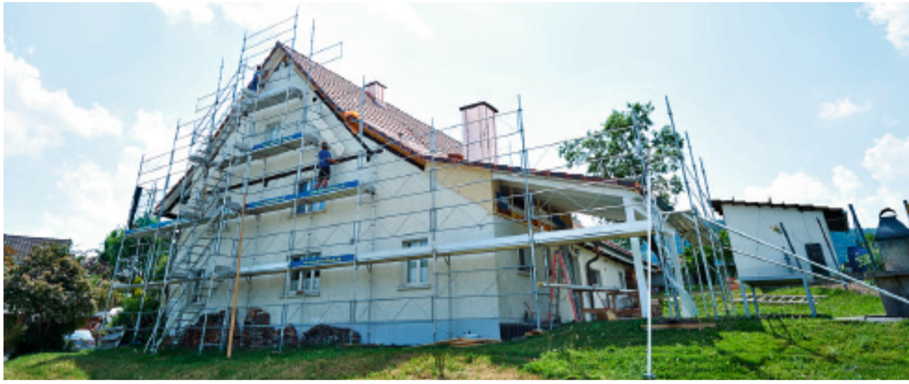
Rénovation: amélioration de l'isolation de l'ancienne ferme à Windlach ZH avant la pose de la pompe à chaleur.
