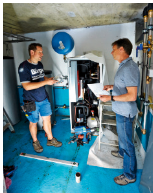
L'ancienne citerne à mazout chez Bucher à Windlach: Daniel Kunz (à d.) et le chauffagiste Markus Baumgartner lors de l'installation d'une pompe à chaleur.
