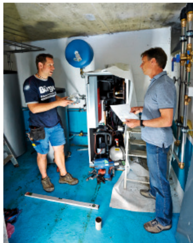
Il locale dell'ex serbatoio di gasolio di casa Bucher: Daniel Kunz (d.) e l'installatore Markus Baumgartner durante l'installazione di una pompa di calore.
