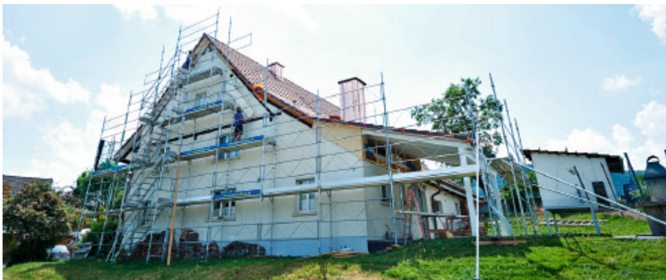
Casa da risanare a Windlach ZH: prima di installare la pompa di calore si rifà l'isolamento dell'ex fattoria.
