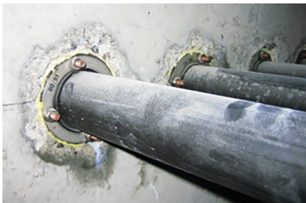
Passaggi dei tubi con guarnizione ad anello nella parete esterna
