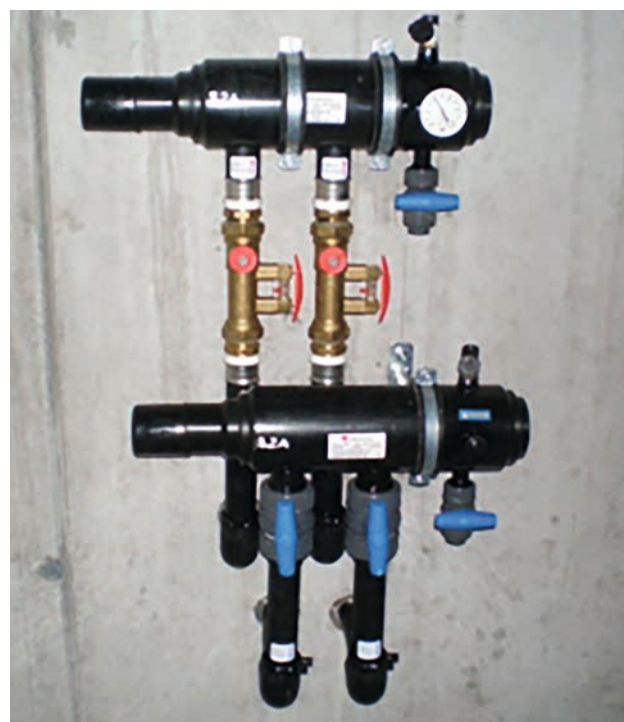
Distributore/collettore con due sonde geotermiche
